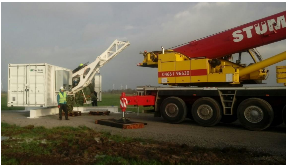
Abbildung 24: Montage der Pilotanlage inkl. Unterkonstruktion und ebenerdigen Betonplatten
